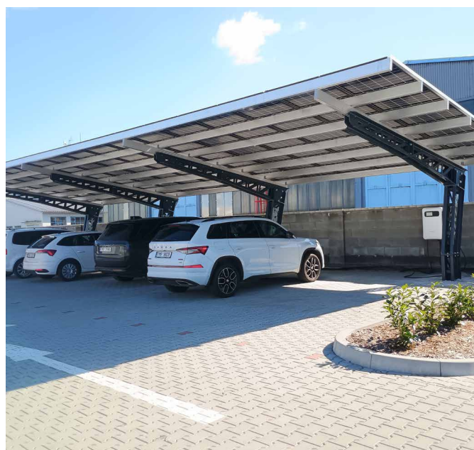
6 parkovacích míst 23 kWp
